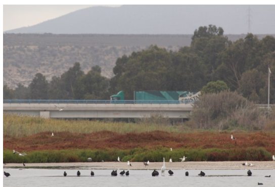
Puente de autopista cruzando el humedal
