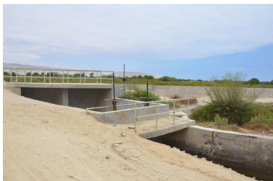
Infraestructura de riego en el humedal
