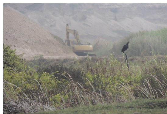
Obras de construcción
